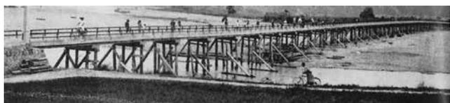
昭和2年（1927）の架け替えの際にようやく板橋から土橋にかわりましたが橋脚は木造のままでした。この橋は、空襲での爆撃で橋の中央部が大きく破壊
