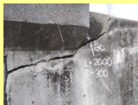
下部工の損傷に対する補修
