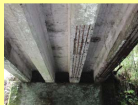
コンクリート桁の損傷に対する補修
