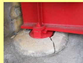
支承の損傷に対する補修
