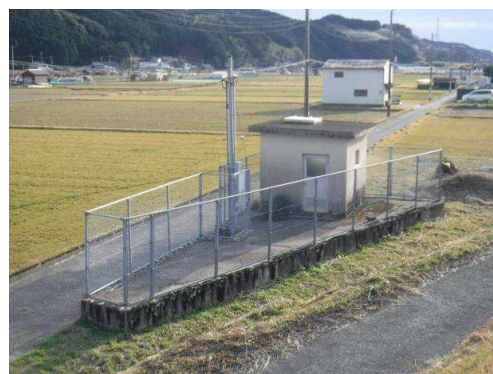
【第2浄水場 3号井】
