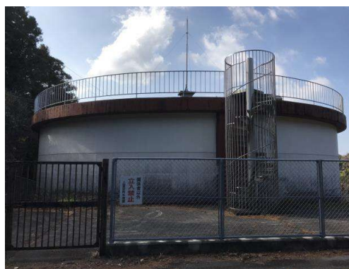
【東部高区配水池】
