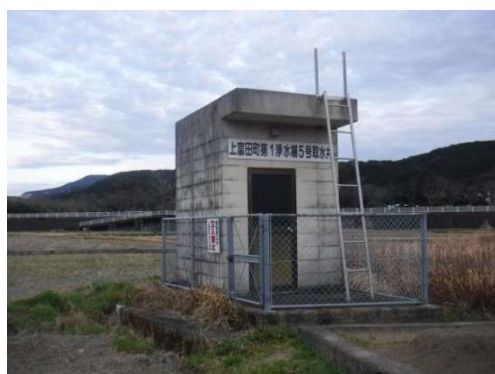
【第1浄水場 5号井】
