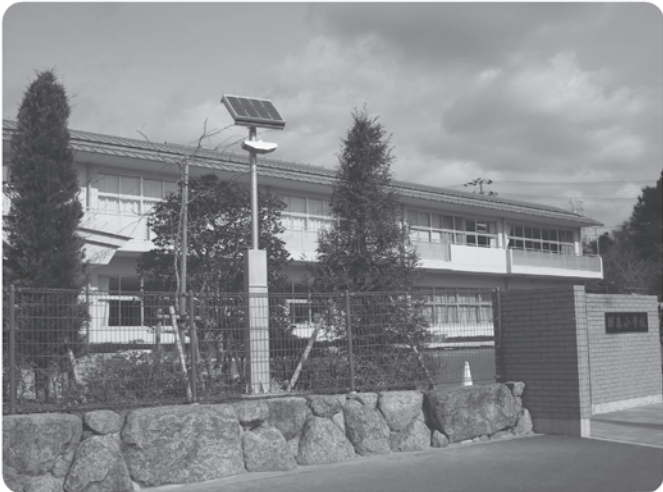
避難誘導街路灯設置事業 朝来小学校校門に設置したソーラーの誘導灯
