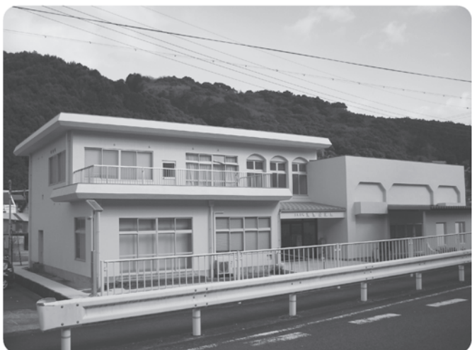
緊急避難施設改修事業 生馬公民館の改修工事
