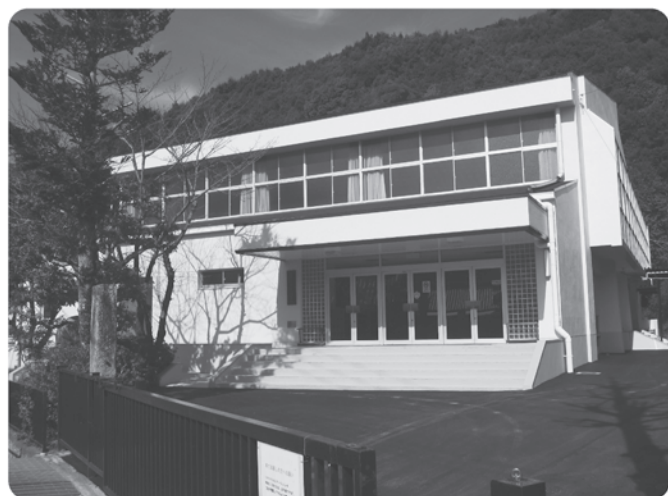
生馬小学校整備事業 耐震改修した体育館
