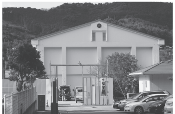
完成が近い岡小学校の体育館 (岡地区) 1月28日撮影
