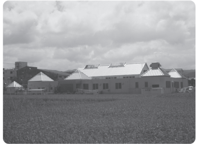
保育所改修事業 朝来第1保育所改修工事(周辺外構工事)
