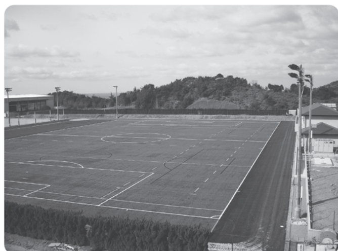
スポーツ施設等整備事業 上富田スポーツセンター多目的グラウンド整備
