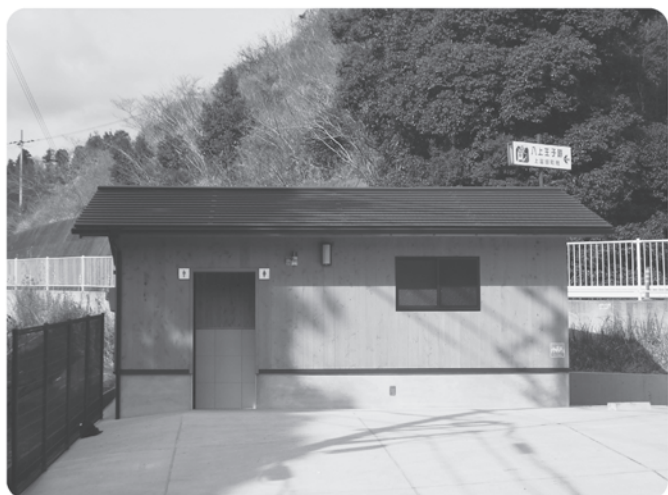
岡地区公衆トイレ設置工事 八上神社(八上王子跡)横にトイレを設置
