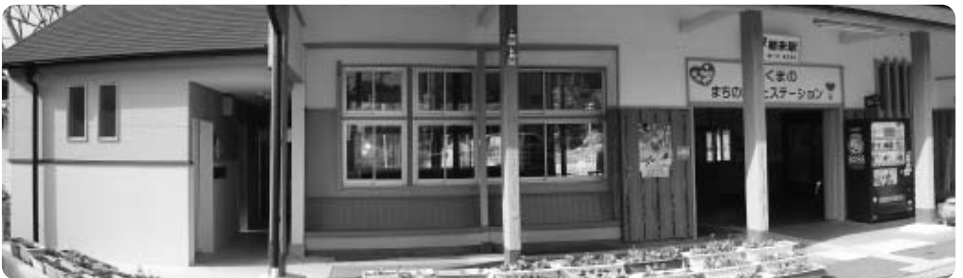
朝来駅駅舎トイレの改修工事(平成19年3月30日完成)
