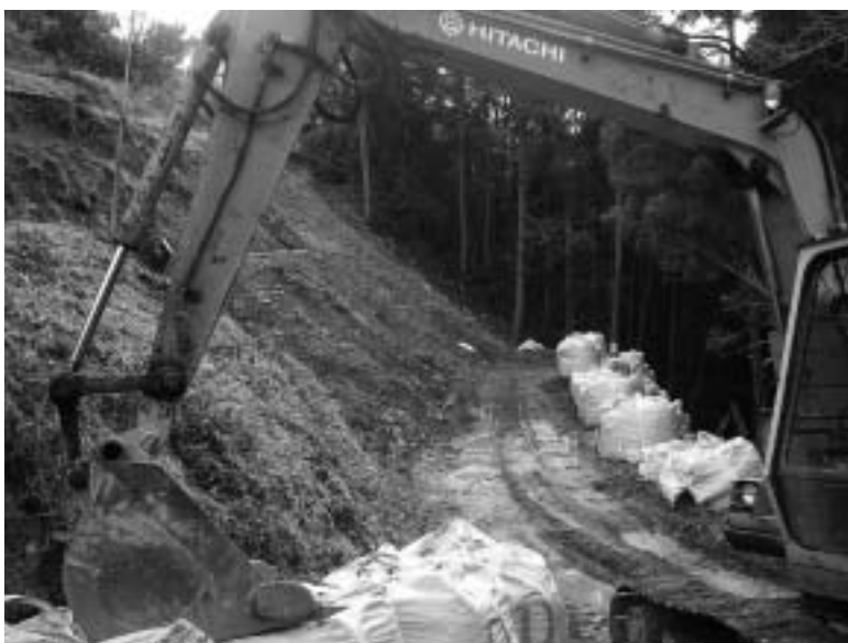
町道射矢ノ谷線道路災害復旧工事(岡地区)
