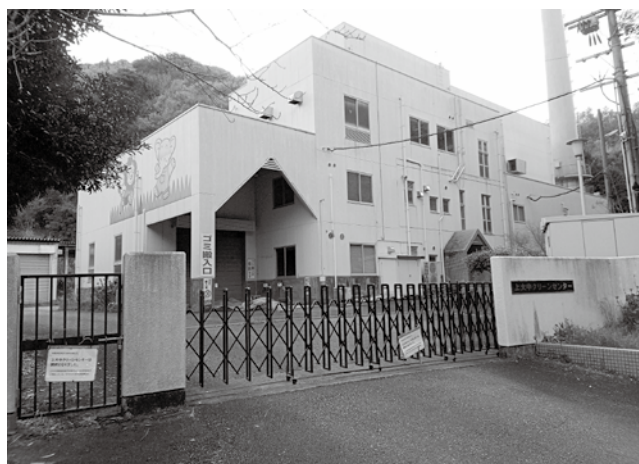
解体予定の上大中クリーンセンター
