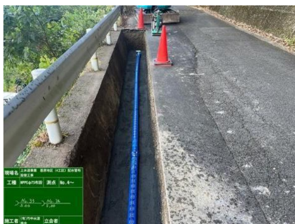
耐震性を備えた水道管への更新
