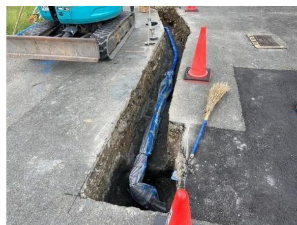
耐震性を備えた水道管への更新
