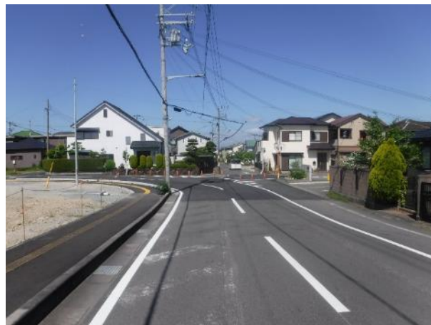
道路改良（南紀の台地区）
