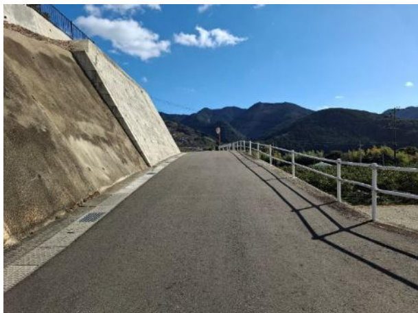
道路改良（下鮎川地区）
