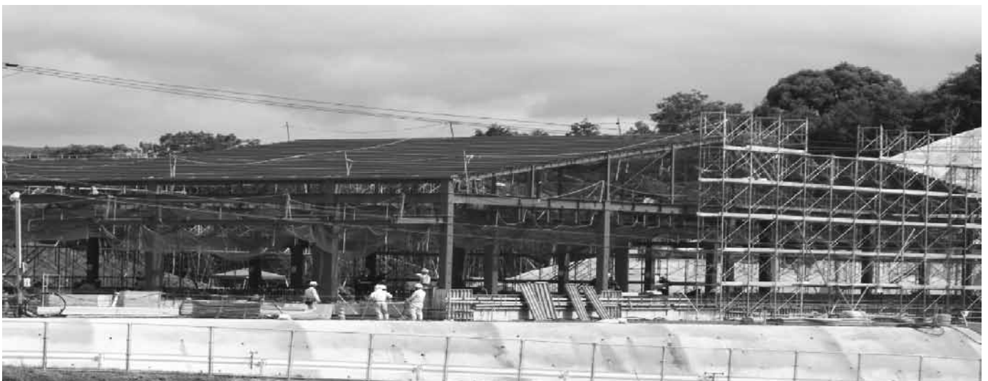
7月中旬頃の給食センター建設工事進捗状況
