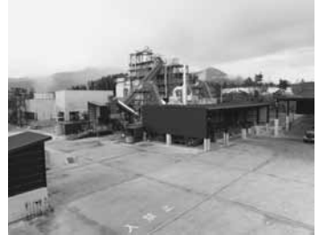
循環流動層式ボイラ
