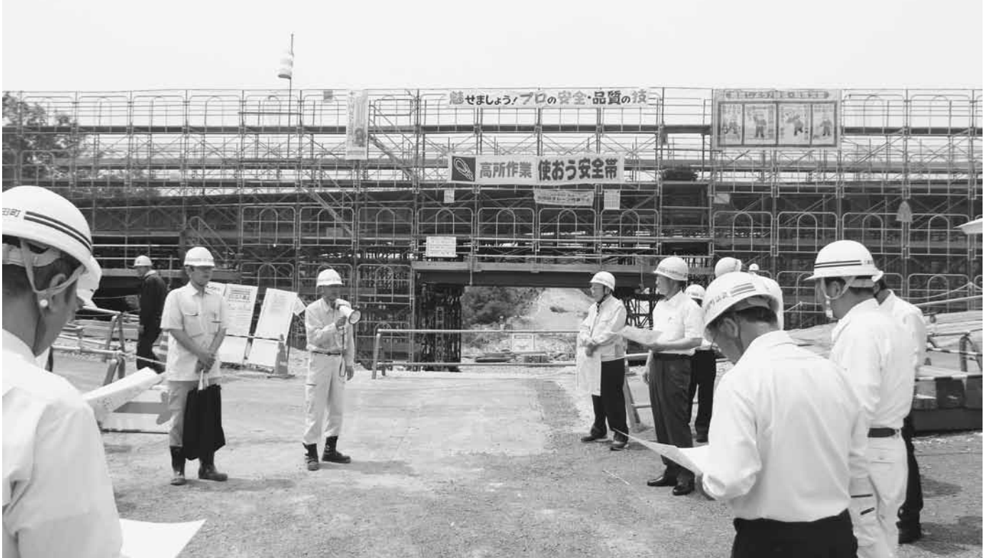
岩崎地区「道の駅くちくまの」建設予定地付近
