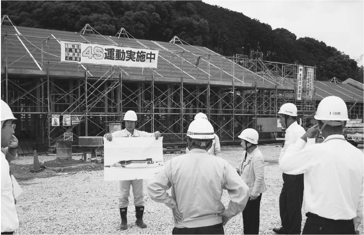
統合保育所建築現場
