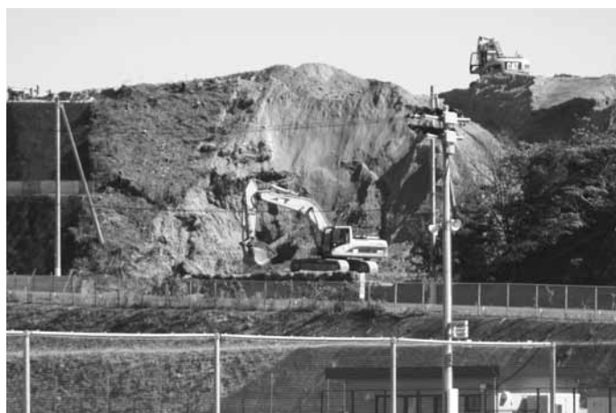
現在造成中の給食センター建設予定地
