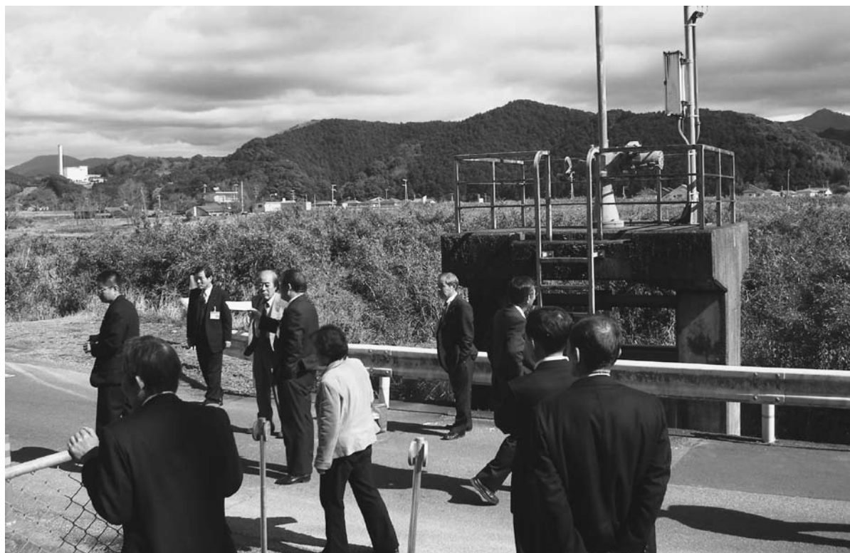
野田排水ポンプ場
