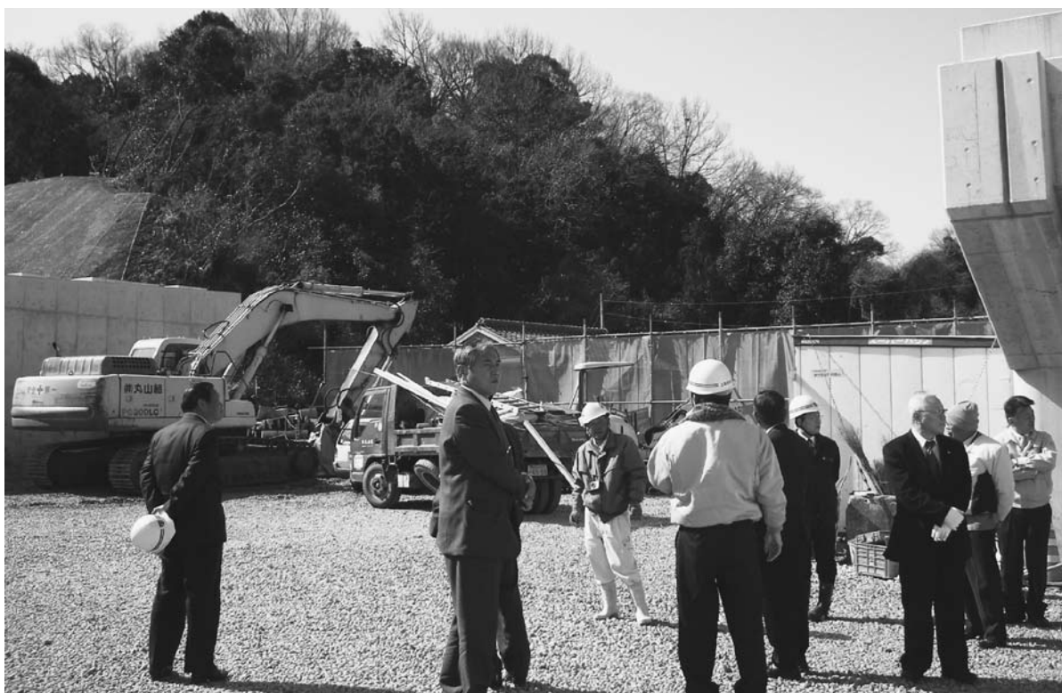
新川工事用道路建設現場
