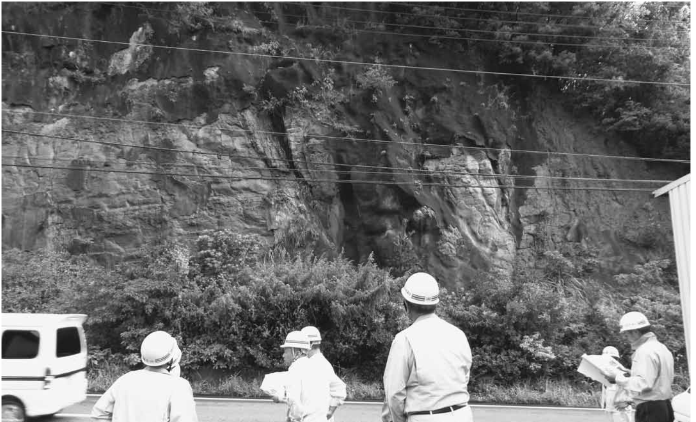
南紀の台1号線現場
