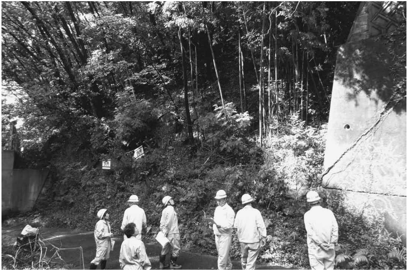
町道中心線現場
