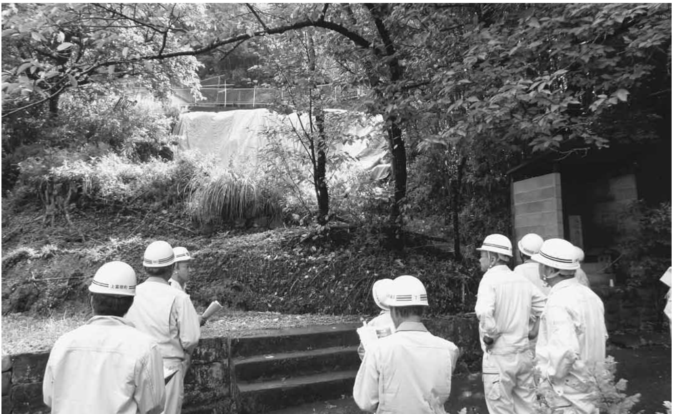
町道学校線現場
