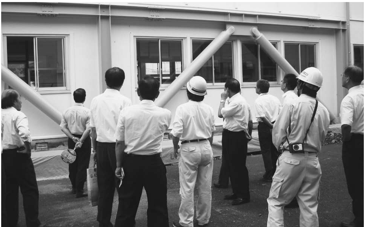
上富田中学校（耐震工事）現場
