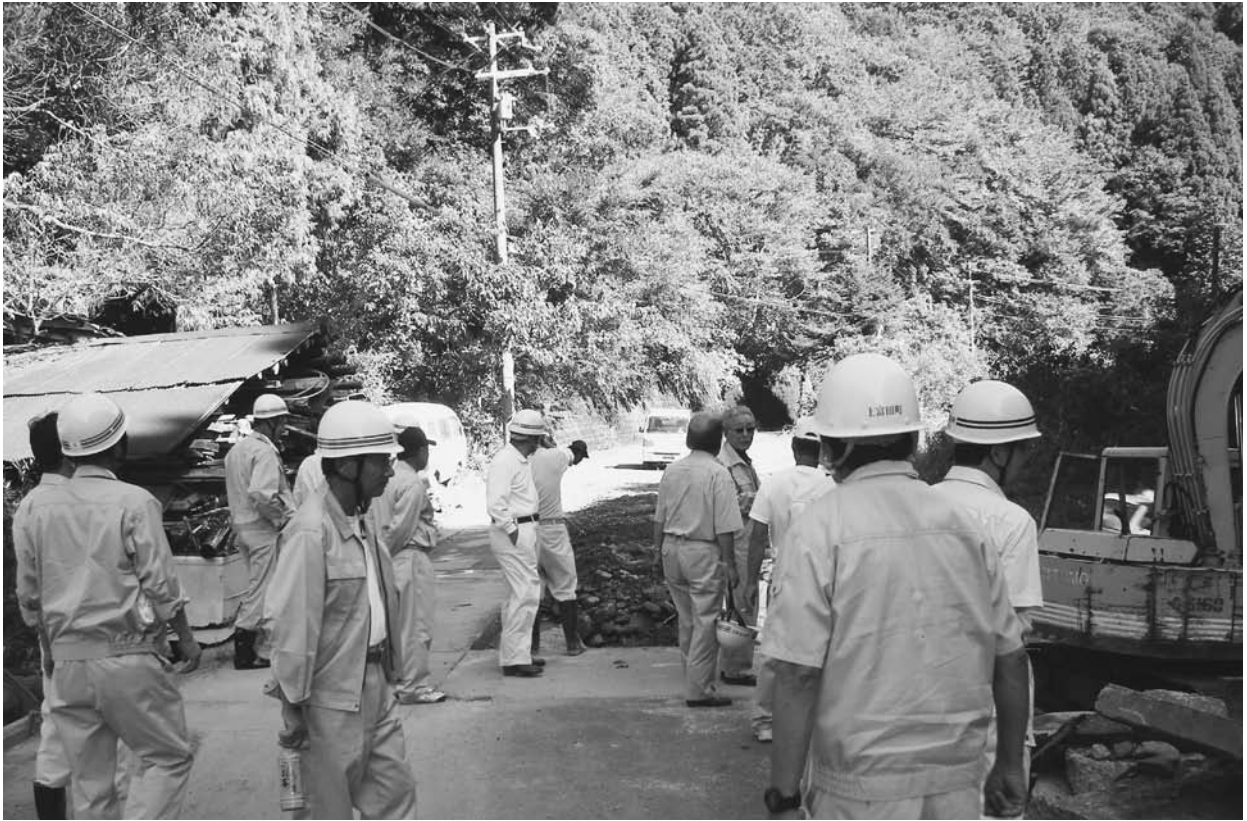
生馬板木地区護岸決壊流出
