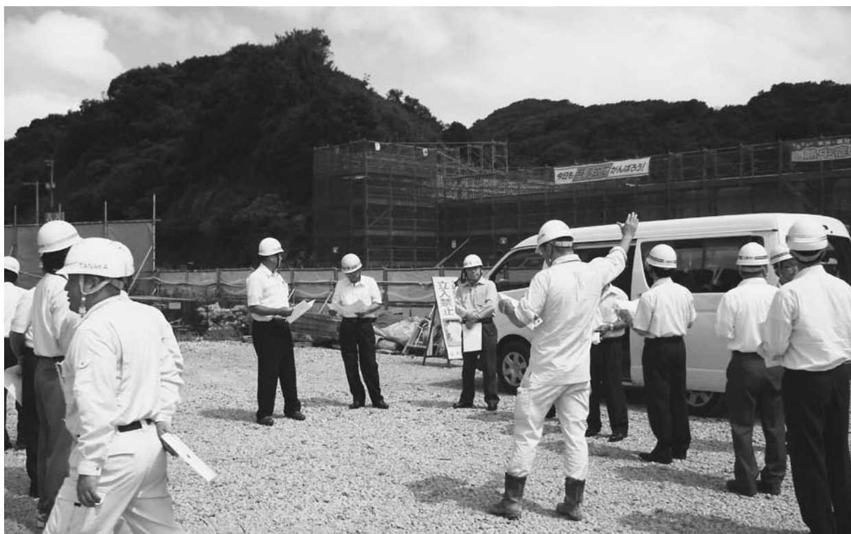
岩崎野田地区函渠工事現場
