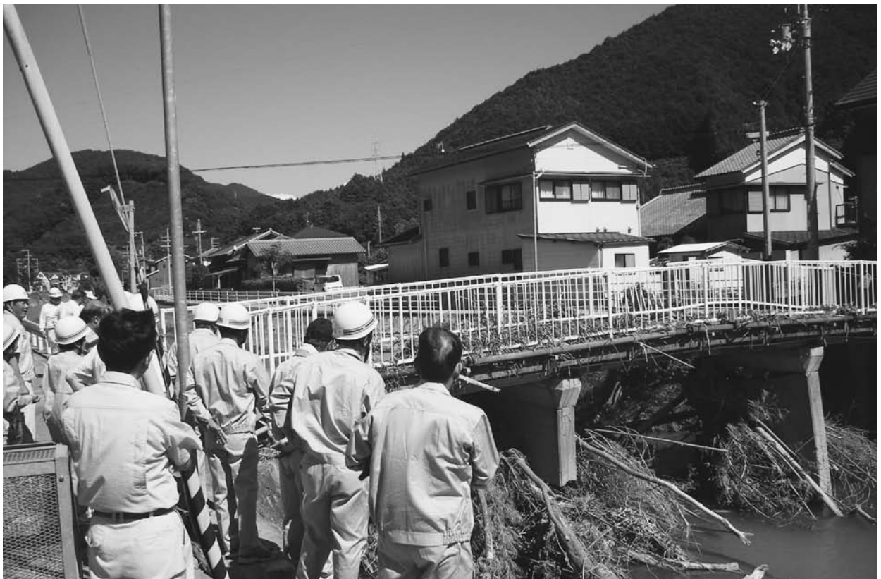
生馬白滝地区白滝橋橋脚、橋台破損
