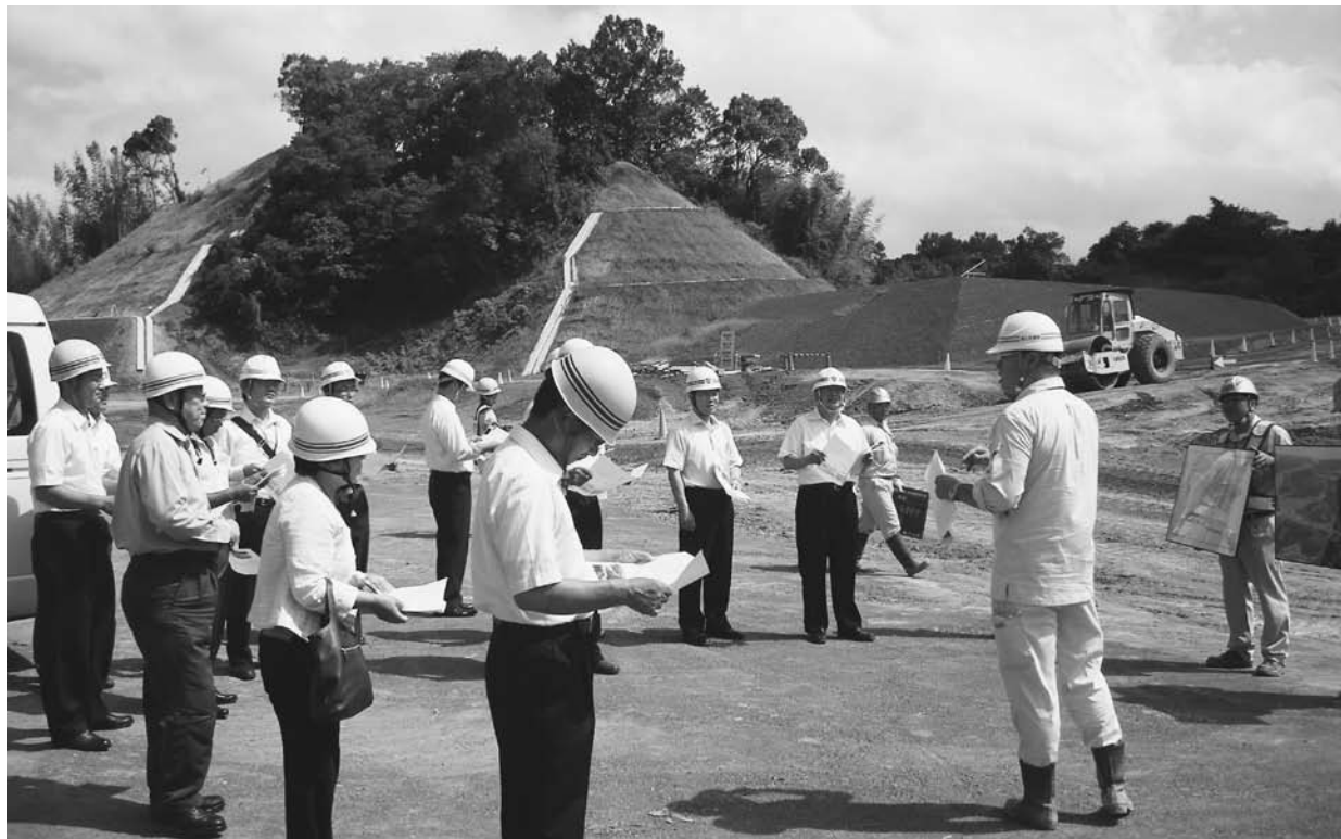
朝来峠地区改良工事（朝来峠インター）現場
