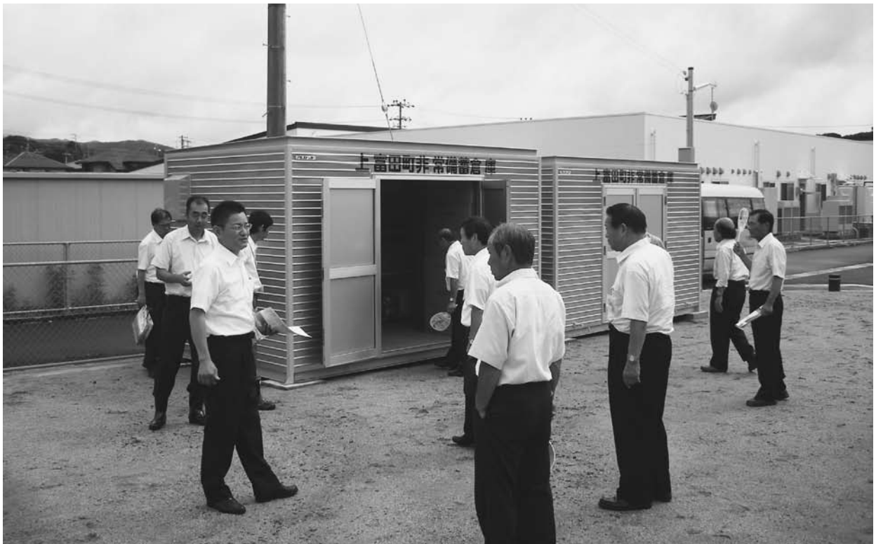
朝来防災公園（防災備蓄庫）現場
