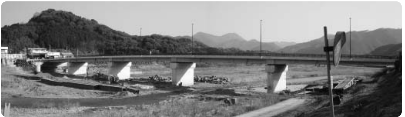
市ノ瀬橋改良工事（事業期間は平成14年度から平成20年度） 旧橋もほとんど撤去されました。2月6日撮影
