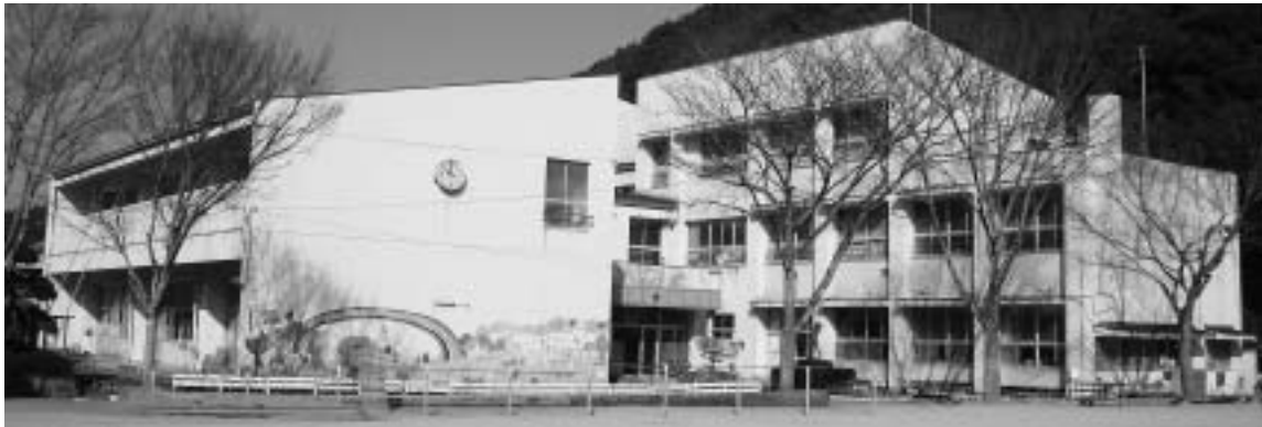
耐震改修工事を行う生馬小学校（昭和55年度建設）
