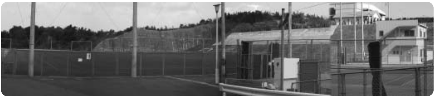
スポーツセンター整備工事（球技場の管理棟建築と張芝改修工事）
