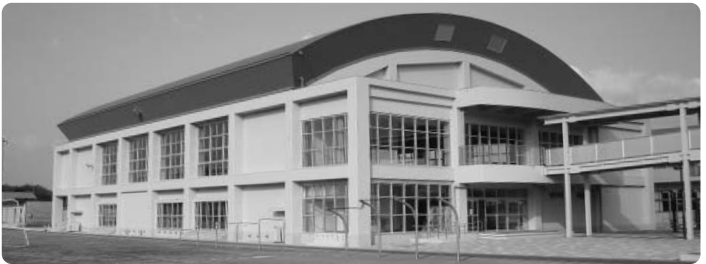
朝来小学校屋内運動場建築工事
