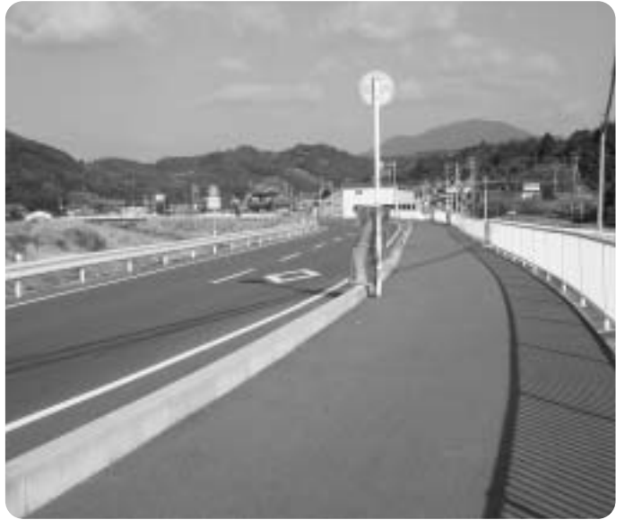
県道上富田南部線改良工事(岡地区)
