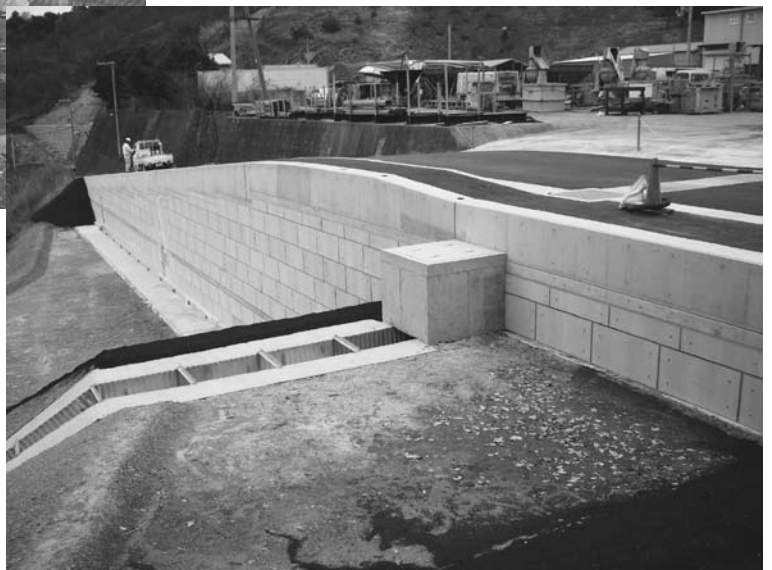
災害復旧事業現年発生公共土木 (町道救馬谷東線)
