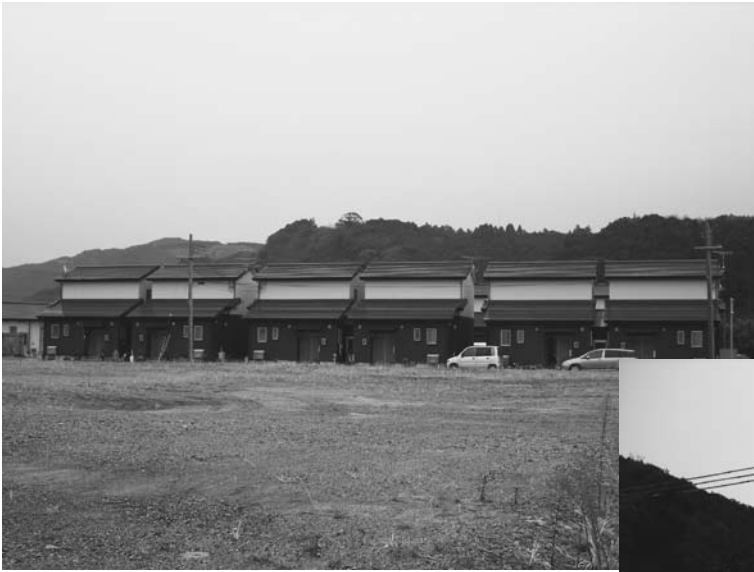
公営住宅建設事業 (生馬橋住宅)
