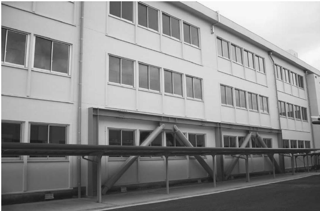
二重鋼管ブレースによる耐震工事
