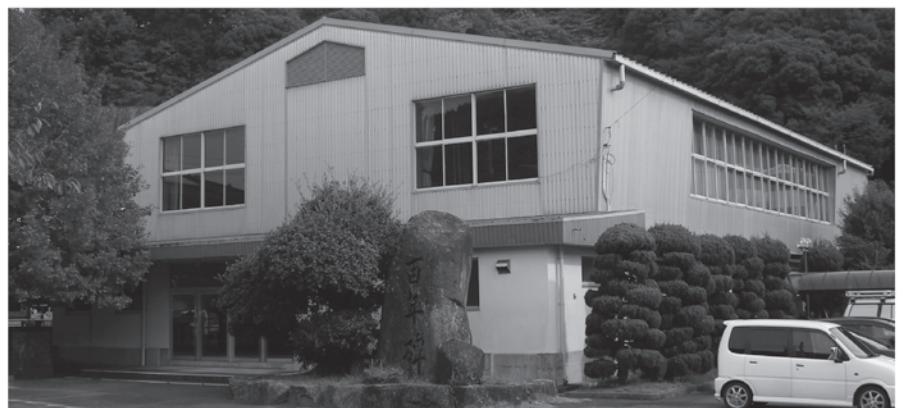
今回建替える岡小学校の体育館
