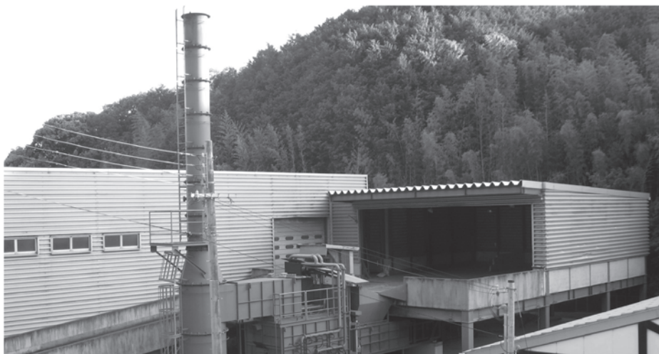
撤去される 共同作業場の焼却設備 （写真中央のエントツ部分）
